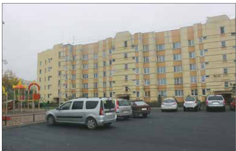
Новая автостоянка возле ул. Полевой, д. 5
