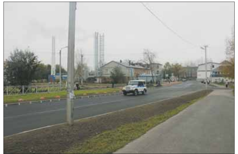
Отремонтированная дорога на ул. Школьной
