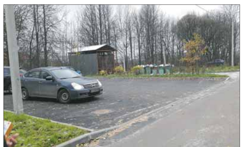
Заасфальтированная автостоянка в деревне Капитолово
