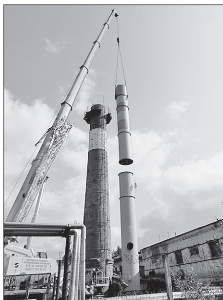
Замена оборудования и трубы котельной № 2
