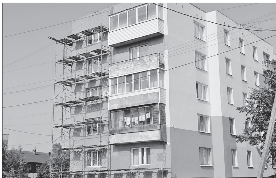
Ремонт фасада на Клубном, 5
