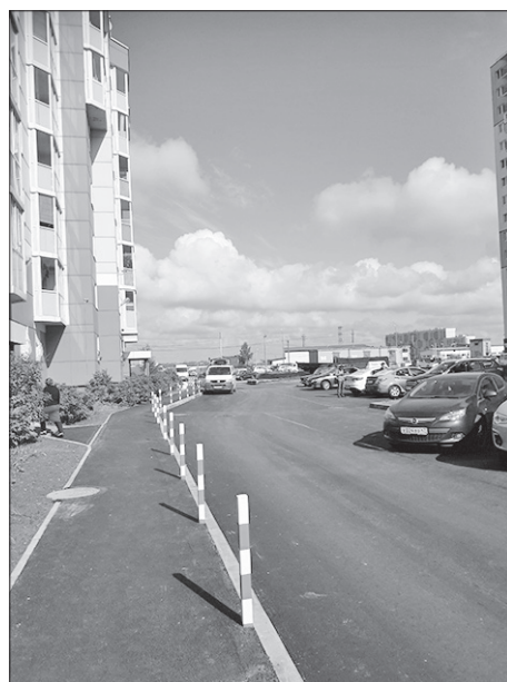
Ремонт дорожного полотна и благоустройство тротуаров
