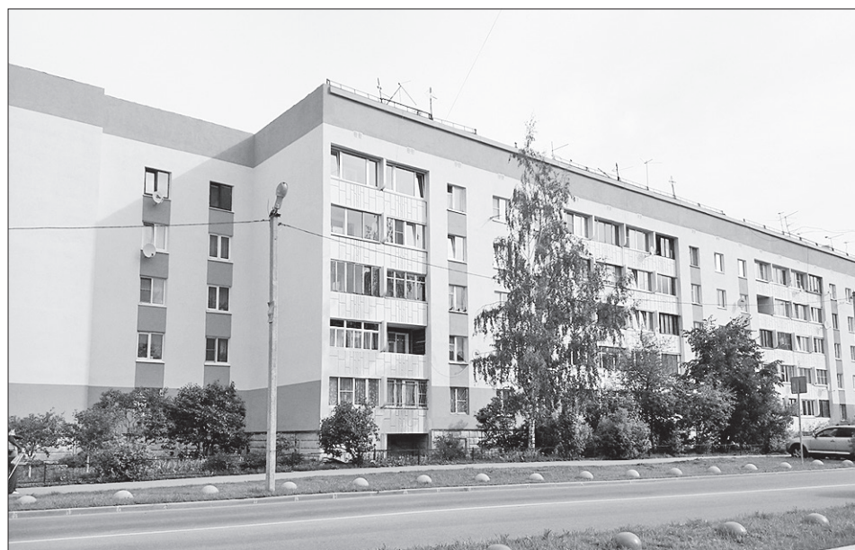
Утепленный фасад на ул. Школьной, дом 4
