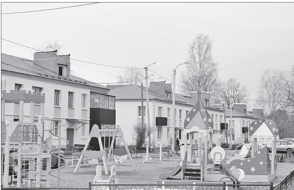
Новый детский комплекс и ремонт фасадов домов на ул. Полевой
