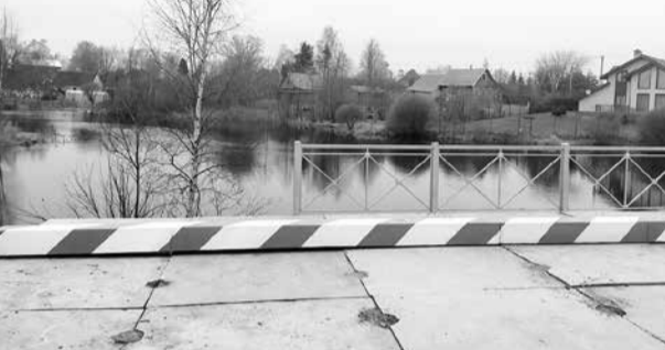
Пожарный водоём в д. Порошкино
