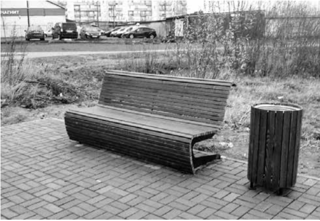
Установка скамеек на ул. Школьной
