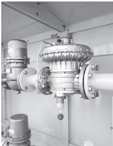
Монтаж ГРПШ на котельной № 29
