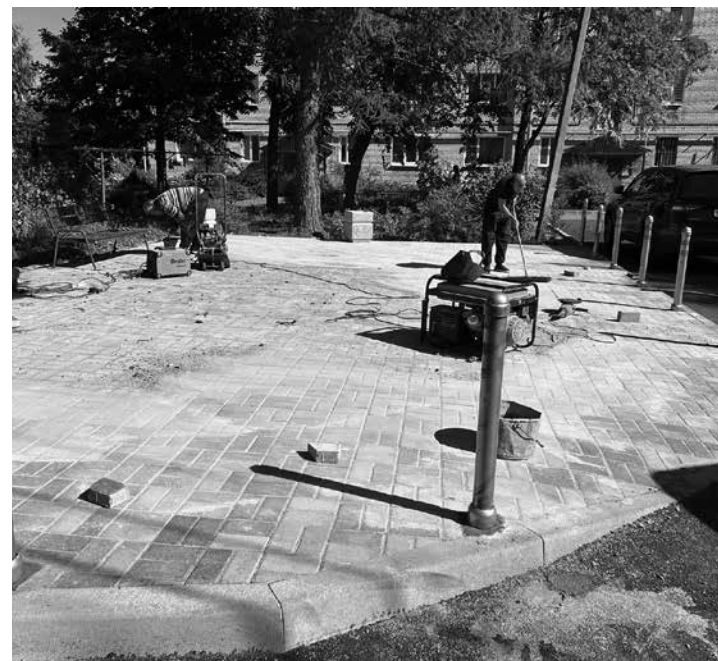
Комплексное благоустройство территории ул. Шоссейной, 10
